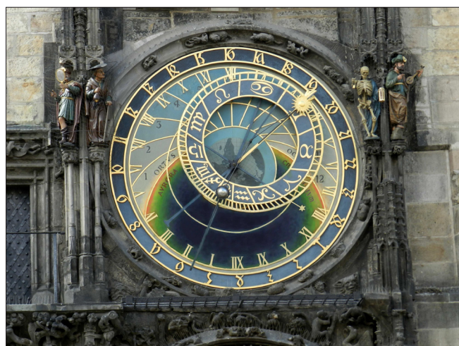
Obr. 21: Rekonstrukce podoby omalby astrolábu provedená podle starých popisů a podle nalezené nápodoby orloje z poč. 20. století (foto a barevná úprava autor).
