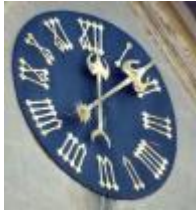
Obr. 14. Historizující ciferník kostela sv. Jakuba v Hostivicích z poč. 20. stol. zachovává pouze schéma velikostních poměrů ruček starých ciferníků s vnitřním minutovým ciferníkem a malou ručkou minutovou. Delší ručka má na tomto ciferníku proto větší plochu, její funkce je ale minutová. Vnitřní ciferník minutový není vyznačen, k chybnému čtení času zde nedochází.
