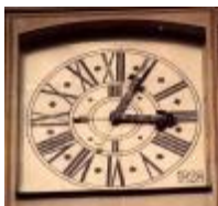
Obr. 10. Ciferník zámku Březnice (okres Příbram). Zřejmě s osazením nového hodinového stroje (na počátku 20. století) byly také na ciferníky osazeny nové ručky. Vnitřní minutový ciferník byl přitom zachován.
