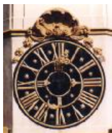
Obr. 9. Pražská Loreta. Ciferník z konce 17. století, u kterého byly později ručky vzájemně zaměněny. Původně hodinová ručka dnes ukazuje minuty a po minutovém ciferníku obíhá ručka hodinová.
