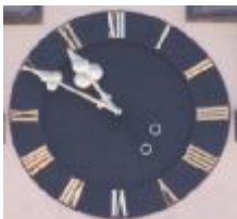
Obr. 12. Ciferník kostela sv. Jiljí v Nymburce (1856) zhotovený již podle dnes běžného schématu, ale s respektováním výrazného rozdílu ve velikosti ploch ruček. Delší ručka s malou plochou je minutová - výraz „velká“ lze použít, jen když máme na mysli její délku.
