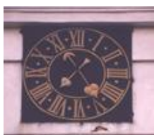
Obr. 8. Ciferník na věži zámeckého kostela Nanebevzetí Panny Marie na zámku Loučeň. V roce 1848 se prováděla oprava kostela a do věže byl osazen nový hodinový stroj. Při této opravě byl na ciferníku nalezen letopočet 1780 a pod ním 1726. Ciferník musel mít původně barokní schéma, ale při některé z pozdějších oprav (buď již v r. 1848, spíše však až později), byl vnitřní ciferník minutový vynechán a ručky byly na hřídelích vyměněny. Větší ručka s velkou plochou ukazuje minuty. Ciferník má na první pohled stále charakter ciferníku barokního, ručky je zde ale nutné číst obráceně. Menší ručka je hodinová.
