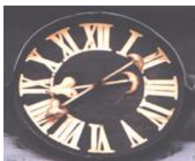
Obr. 5. Původně barokní ciferník kaple Zvěstování Panny Marie zámku Karlova Koruna (Chlumec nad Cidlinou, F. Londensperger okolo 1765). Ciferník po úpravě, při které bylo rameno hodinové ručky zkráceno a rameno minutové ručky prodlouženo, vnitřní ciferník minutový byl vypuštěn.
