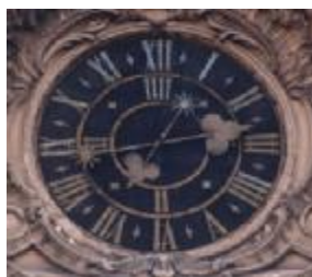
Obr. 3. Původní barokní ciferník (S. Londensperger 1774) na zámku Měšice. Menší ručka je minutová. Tenká raménka ruček byla vždy viditelně odlišena od pozadí v celé své délce i s protizávažími.
