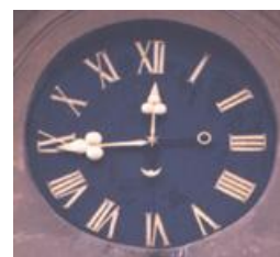
Obr. 4. Ciferník zámku Poděbrady (Jan Janata 1870) si zachoval dodnes minutovou ručku jako kratší, vnitřní ciferník minutový ale nebyl patrně nikdy vyznačen. Schéma ruček mohlo být jen převzato z předchozího ciferníku staršího. Celkový charakter ruček s již výraznějšími rameny zde působí mnoho omylů v odečítání času. Stejný typ ciferníku se dochoval na evangelickém kostele v Libici (Jan Mareš, 1895) nebo na ev. kostele v Chlebích.
