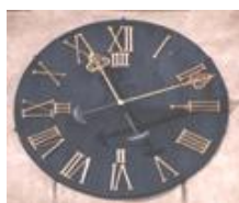
Obr. 11. Ciferník kostela sv. Vavřince v Novém Bydžově. Má-li ciferník vyznačen vnitřní ciferník minutový, měla by být minutová ručka kratší. Tady však bylo rameno minutové ručky později výrazně prodlouženo a rameno hodinové ručky nejspíš trochu zkráceno. Bylo zde přitom zachováno (nepochybně z estetických důvodů) již nefunkční vyznačení vnitřního ciferníku minutového. Takto upravovaných ciferníků není mnoho (podobně např. zámek Lužany).
