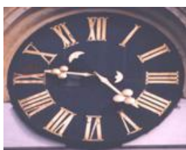
Obr. 6. Ciferník evangelického kostela v Opolanech (Jan Mareš 1898) byl původně koncipován stejně jako ciferník nedalekého zámku Poděbrady - s kratší ručkou minutovou. Zde byly ale později ručky prokazatelně na hřídelích vyměněny. Minutovou ručkou je nyní delší ručka s velkou plochou. Ciferník je na pohled stále téměř stejný jako ciferník zámku Poděbrady (obr. 4), ale ručky mají opačnou funkci.
